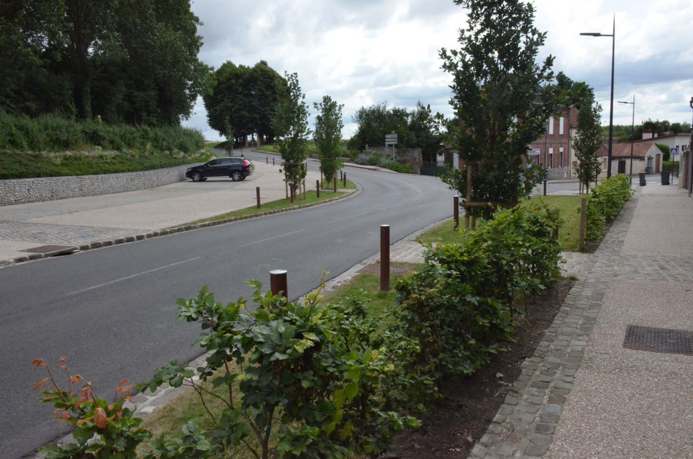
Estrun - aménagement de la traversée communale - 2016 - 510.000 € H.T.
