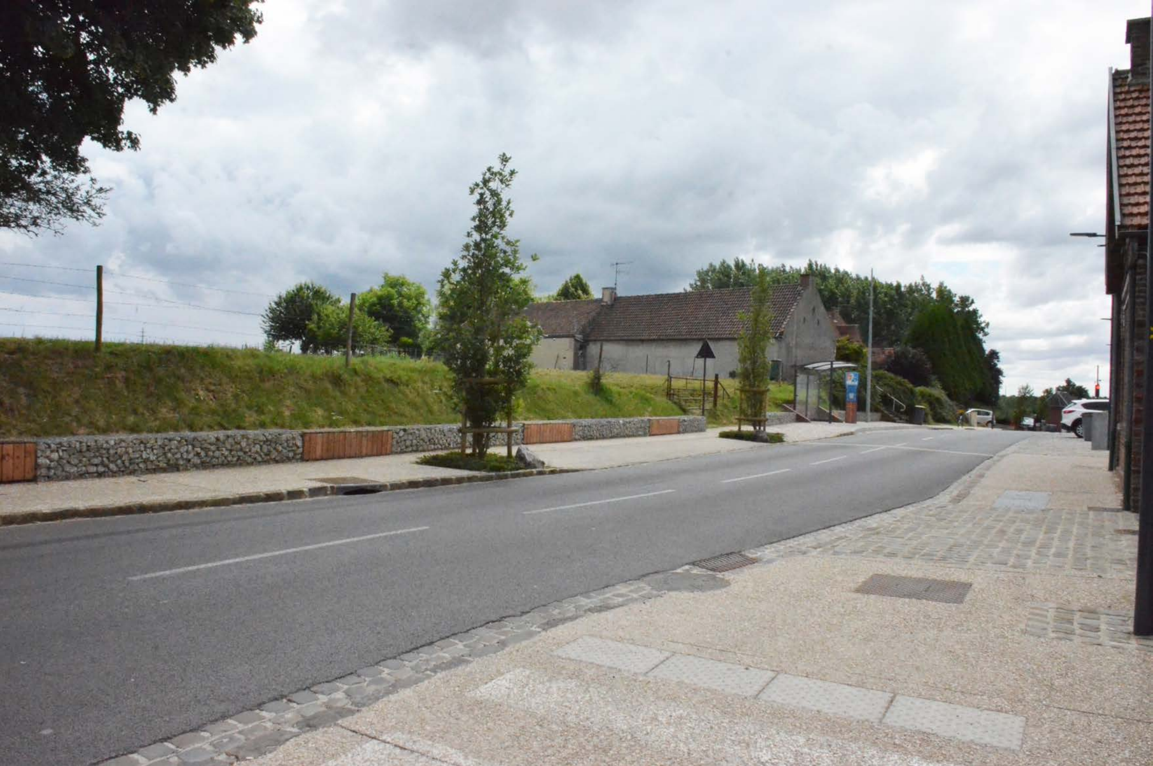
Estrun - aménagement de la traversée communale - 2016 - 510.000 € H.T.
