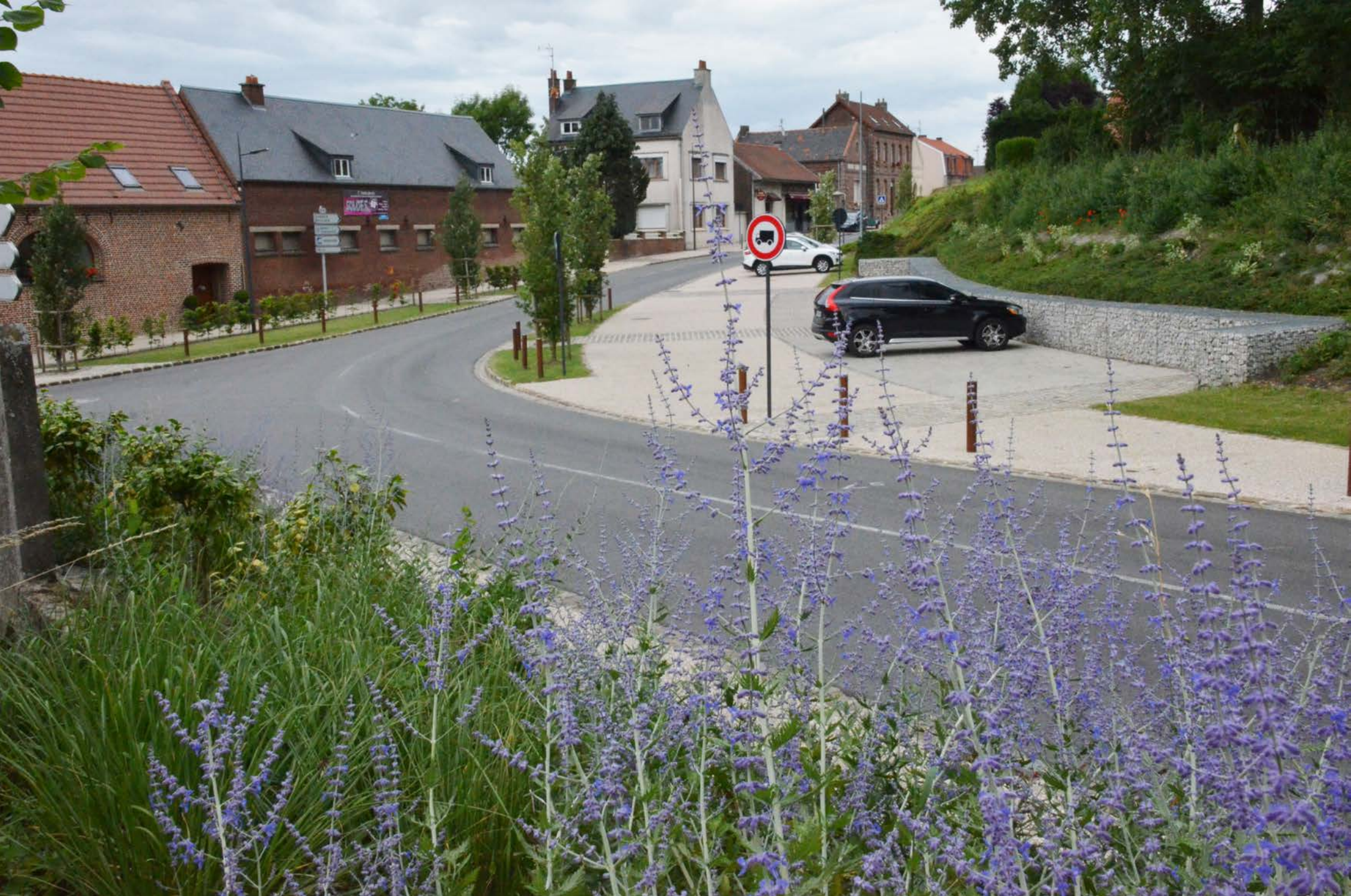
Estrun - aménagement de la traversée communale - 2016 - 510.000 € H.T.
